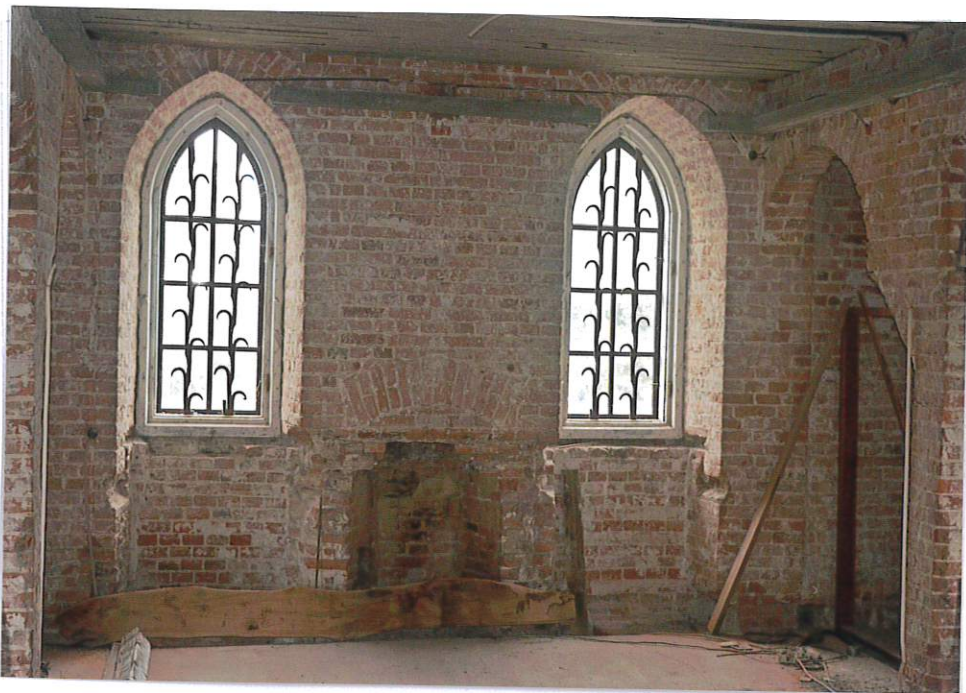
Fot. 10. Wnętrze piętra - kraty okienne i relikty kominka), 2019.
