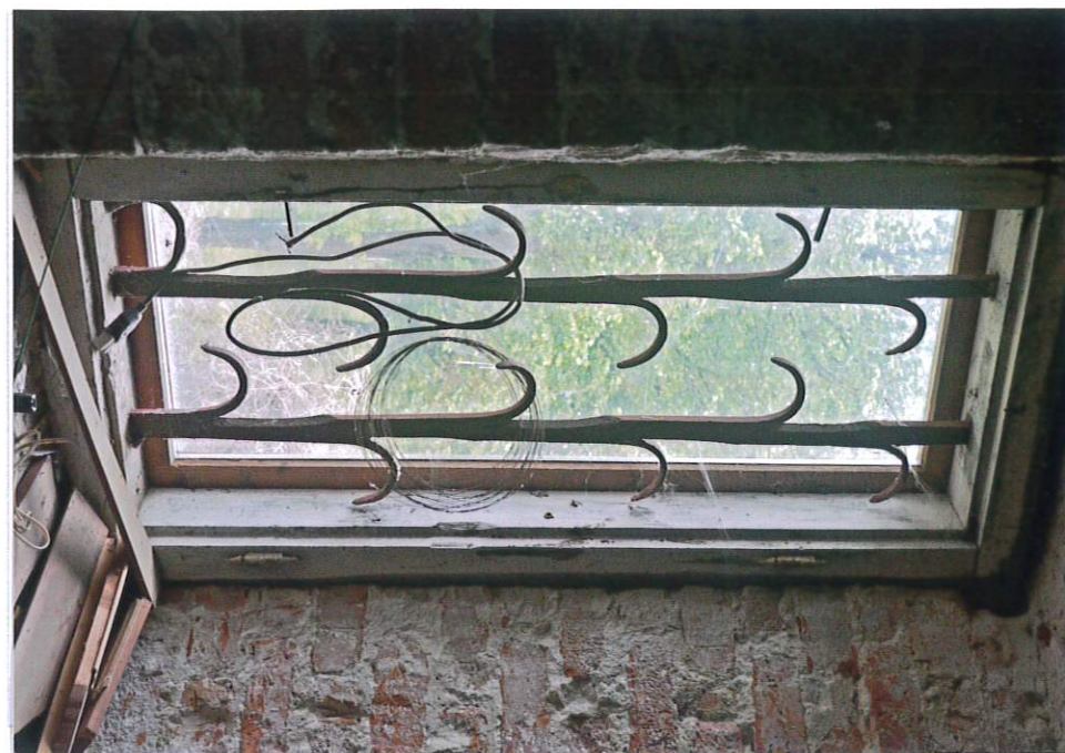
Fot. 11. Wnętrze piwnic - kraty okienne, 2019.
