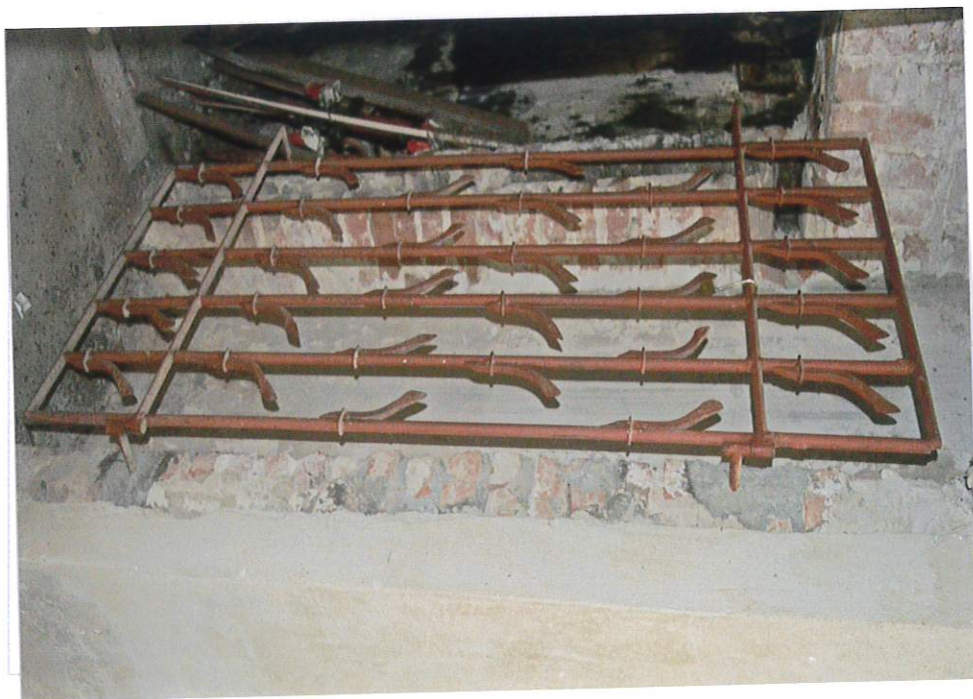
Fot. 12. Furtka (krata) w piwnicy, 2019.
