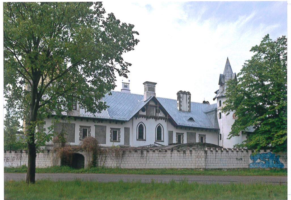
Fot. 6. Elewacja północna - widok z ulicy, 2019.
