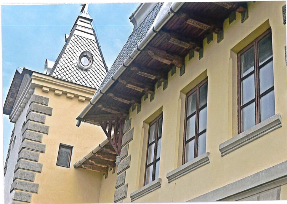
Fot. 3. Elewacja południowa - widok na okap skrzydła wschodniego i wieżę południową, 2019
