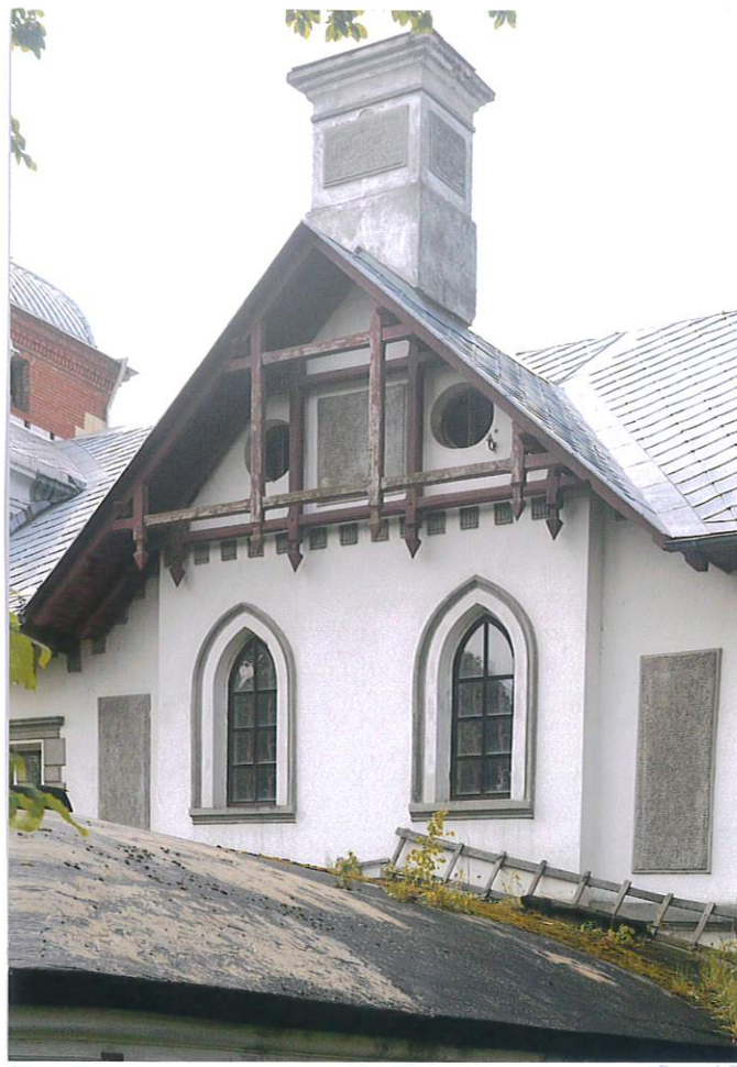
Fot. 8. Elewacja północna – ryzalit, 2019.
